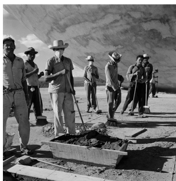
Congresso Nacional em construção, c. 1958
