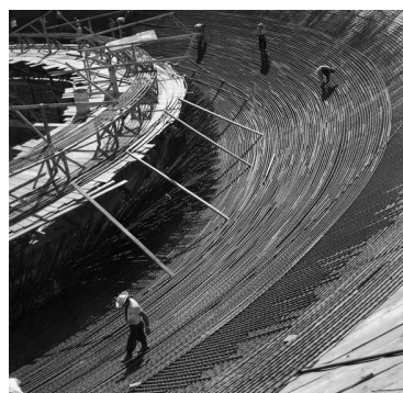
Congresso Nacional em construção, c. 1959
