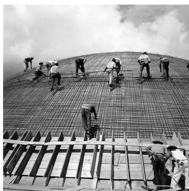
Congresso Nacional em construção, c. 1959
