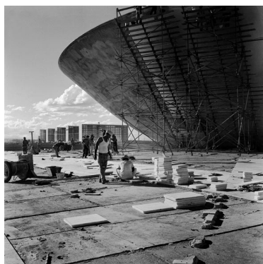
Congresso Nacional em construção, c. 1958
